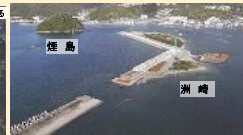
工事中の福良港湾口防波堤
