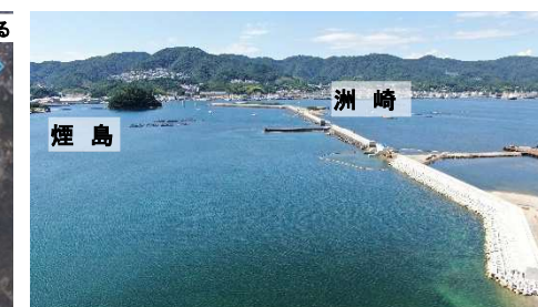
工事中の福良港湾口防波堤
